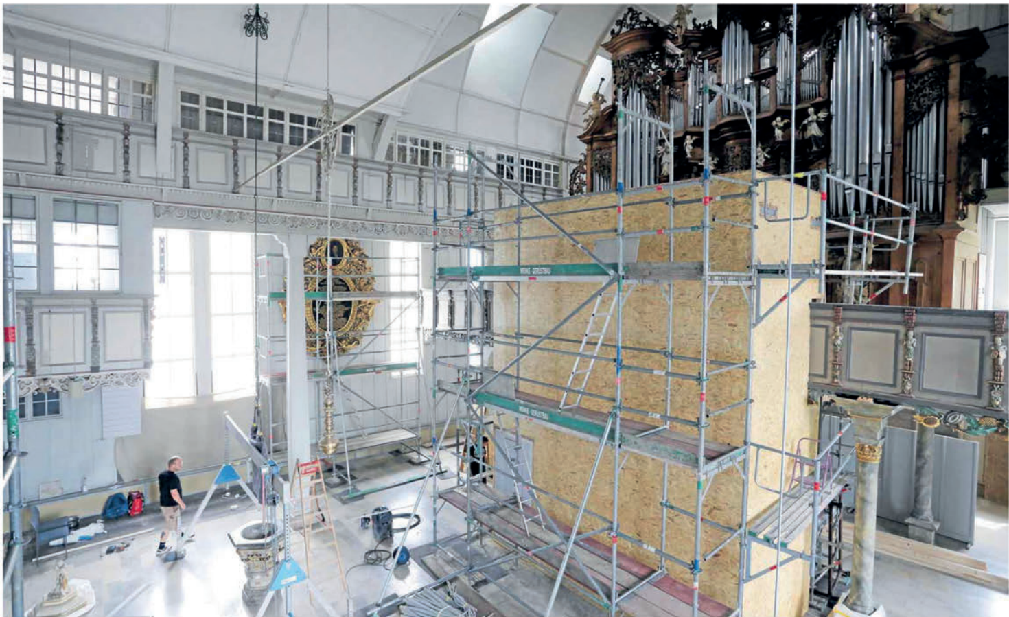
Der Altar ist bereits eingehaust. Nach dem Abbau der Figuren bekommt auch der Orgelprospekt seine schützende Hülle.
